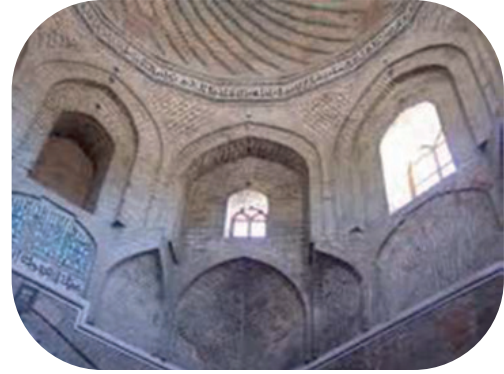
Eski Malatya Ulu Camisi kubbeye geçiş trompları
