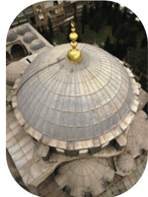
Edirne Selimiye Camisi Kubbesi (Dış Görünüm)
