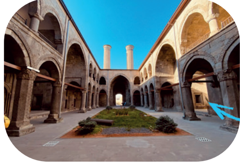
Erzurum Çifte Minareli Medrese Avlu ve Revaklar
